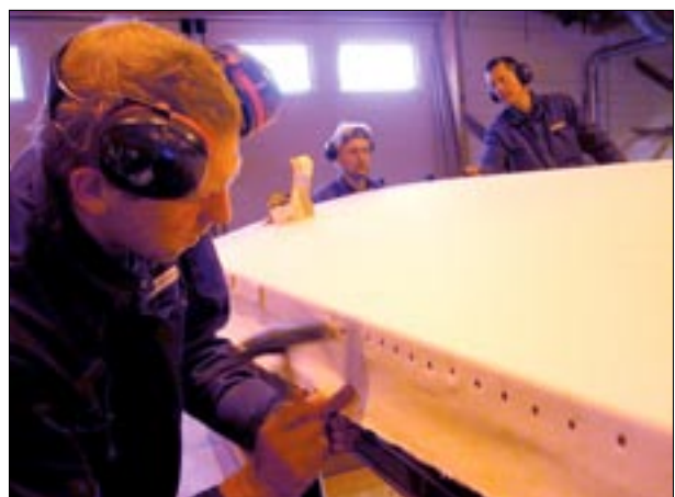
Overgangen mellom hyttesider og tak dekkes av en mahognilist. Uten på denne blir seilduken spikret og kanten av duken blir så dekket av en halvrund eikelist.
