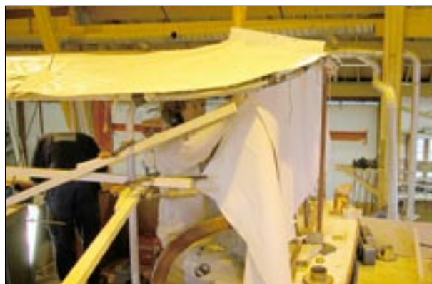
Baldakinen blir skåret til. Under sees jernbøylene.
