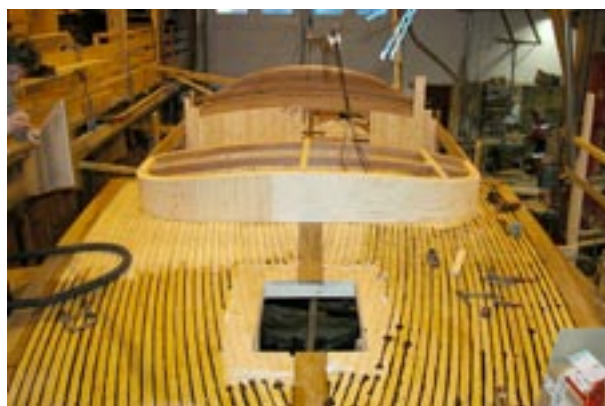
Fordekket er lagt, beket og delvis renskrapet.
