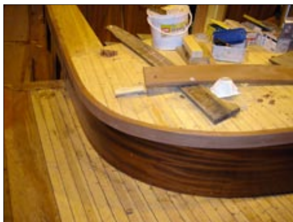
Oppbygging av den bua fronten. Mahognibordet er bøyd i en kraftig bue.
